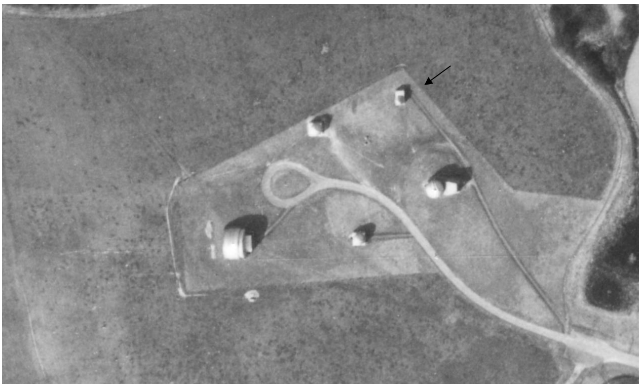
Figur 13: Luftfoto fra 1962, der viser det lille træhus' placering som den nordligste af kuplerne.
